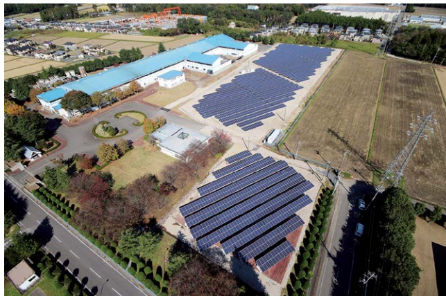
那須工場 太陽光発電所
